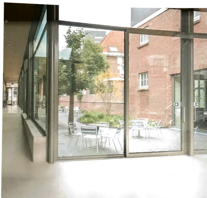
De nieuwe bioscoop bestaat uit twee voorheen gescheiden monumentale gebouwen, het oude Cinecitta en Ruimte X, die door een moderne gaanderij met elkaar verbonden zijn. Het gebouwvolume is teruggebracht naar de oorspronkelijke staat. Een later toegevoegde zijzaal is gesloopt en de oorspronkelijke tuin teruggebracht.
